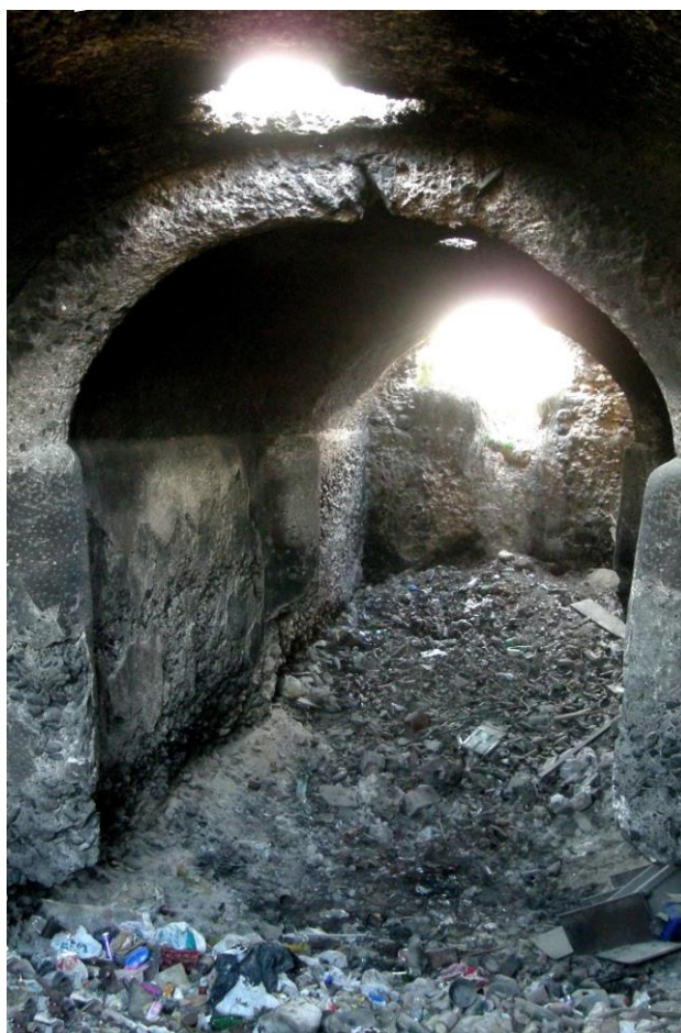
Fig. 19. Interior del Aljibe del Ciprés.
