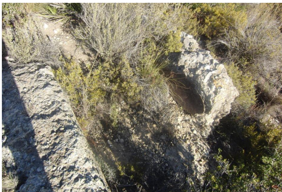
Fig. 3. Detalle del Cajero del antiguo acueducto romano dels Arquets de Baix.
