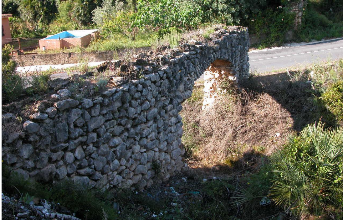
Fig. 7. Acueducto dels Arquets de Dalt, en 2009 antes de su restauración.
