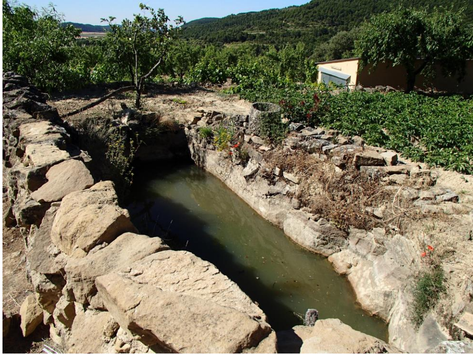
Fig. 10. Ejemplo de huerto con su balsa (recinto 19). Se observa el pilón para riego con quinquinflón .
