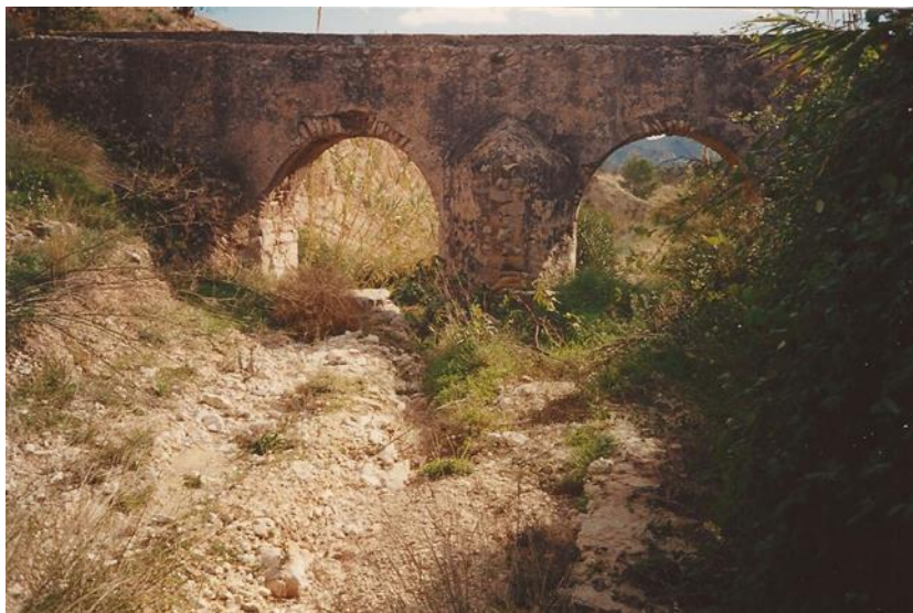
Fig. 6. Acueducto de Soler (l'Alfàs del Pi).
