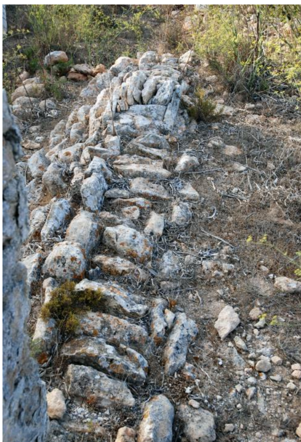
Figs. 3 i 4. Detall de l'extradós de les voltes dels aljubs de Can Xomeu Maians i de Can Xomeu Sord (Fotos: A. Ferrer).
