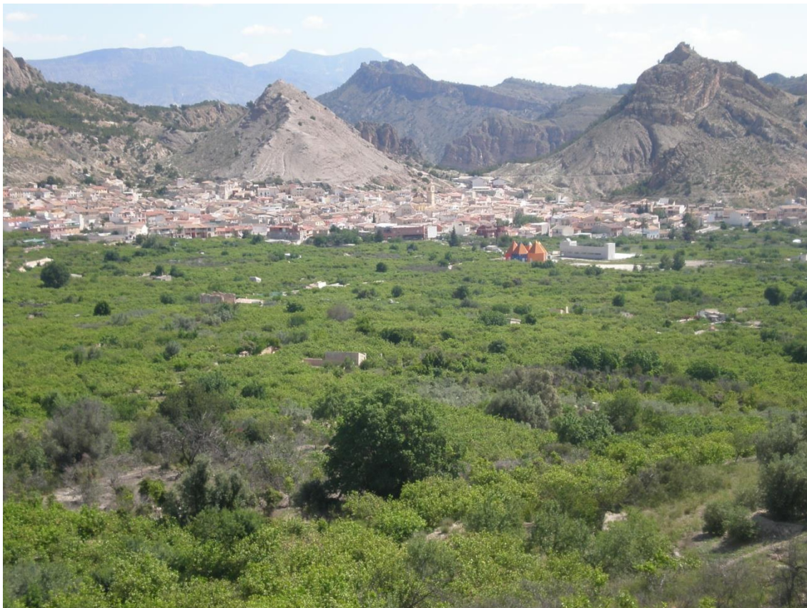
Fig.5. La huerta-oasis de Ricote. Inicialmente basada en las aguas de la Fuente Grande o del Molino, completada con una dotación de aguas elevadas desde el río Segura.
