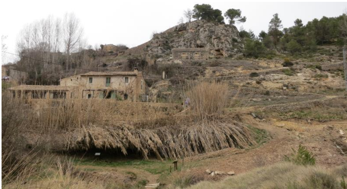
Fig. 4. Partidor de les Aigües (caseta con dos vanos al pie de la peña que domina el paisaje) y Molinos del Partidor (conjunto de inmuebles de arquitectura tradicional al pie del Partidor). A la derecha de la imagen se advierte la acequia recuperada en 2013. Fotografía: Luis Pablo Martínez.
