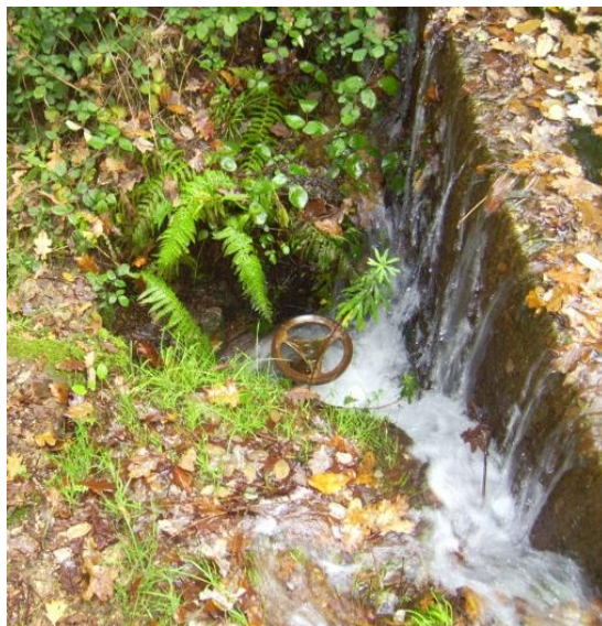
Fig. 5. La industrialización tardía supuso la transformación y modificación de algunas partes de las construcciones tradicionales de regadío. En la imagen, muro de la base de una presa con mecanismo moderno de apertura y cierre, donde antes estaba el buceiro.
