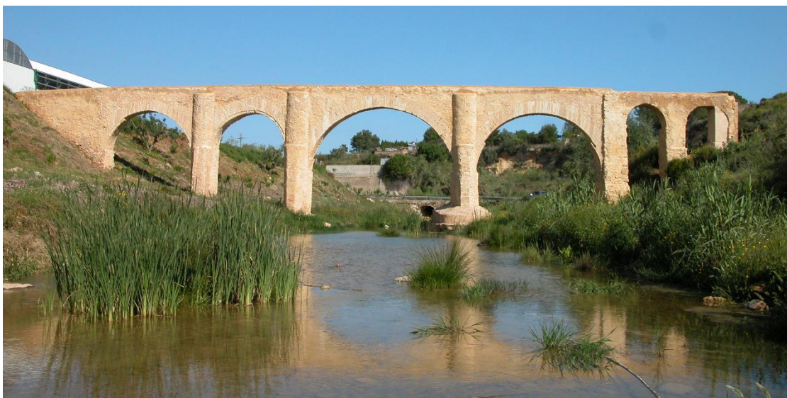
Fig. 2. Imagen del acueducto dels Arquets de Baix.
