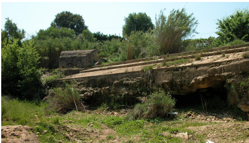
Fig.9. Azud del Pantà de Torrent en 2011, antes de su restauración.
