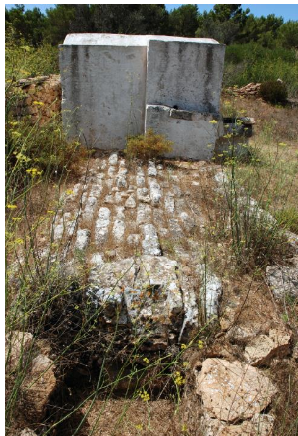
Figs. 3 i 4. Detall de l'extradós de les voltes dels aljubs de Can Xomeu Maians i de Can Xomeu Sord (Fotos: A. Ferrer).
