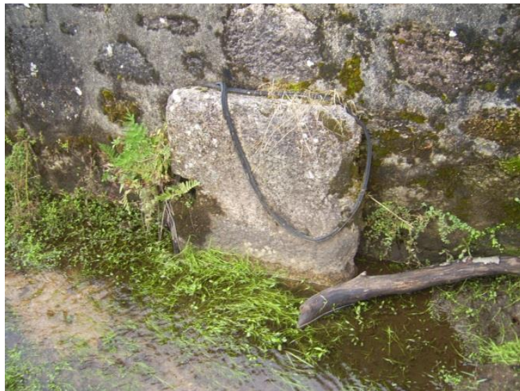
Fig. 3. Pedra de buceiro de grandes dimensiones, actualmente en desuso, apoyada en uno de las paredes de una presa. La sustitución del mecanismo tradicional del buceiro por mecanismos de apertura y cierre modernos han provocado la inutilización de estas piedras labradas, provocando su progresivo abandono y destrucción.
