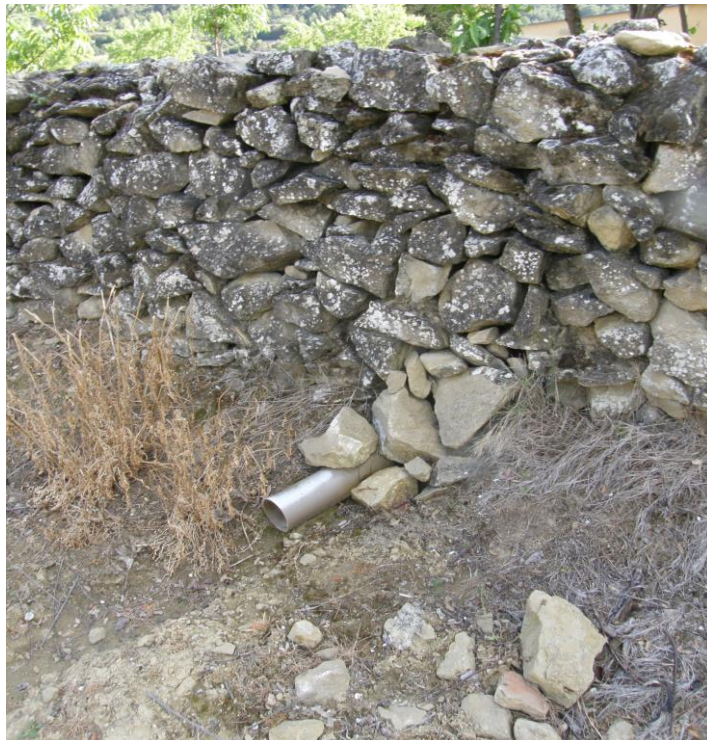
Fig. 11. Desagüe de retorno al camino desde una balsa.
