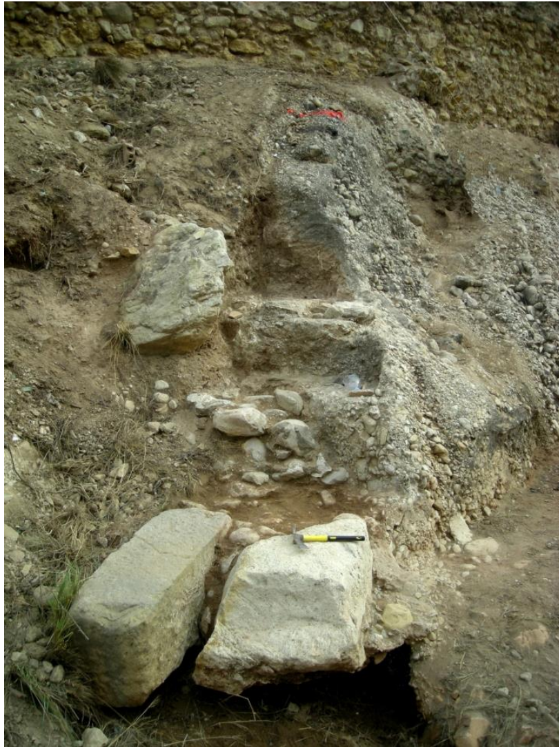
Fig. 3. Estribo oriental. Entalladuras de sillares y espaldón. En la base, canal de desagüe del azud.
