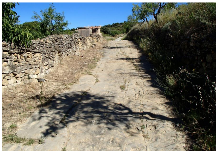
Fig. 6. Tramo en roca del camino, que forma parte del sistema de captación.
