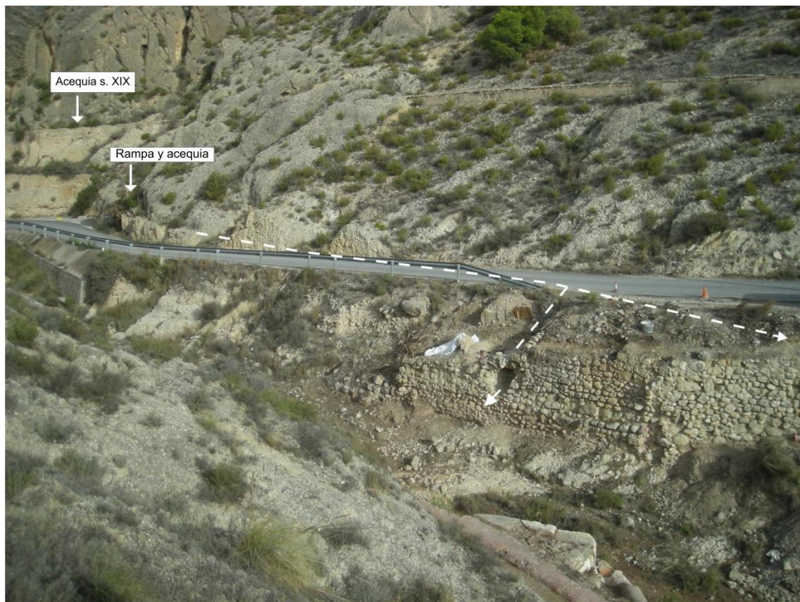
Fig. 7. Rampa del molino.
