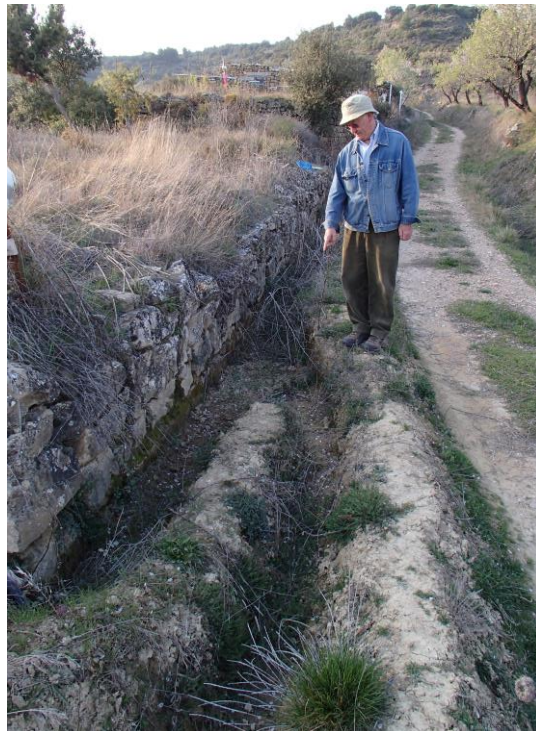
Fig. 9. Partidor de agua de escorrentía en el sistema de riego del Coronazo.
