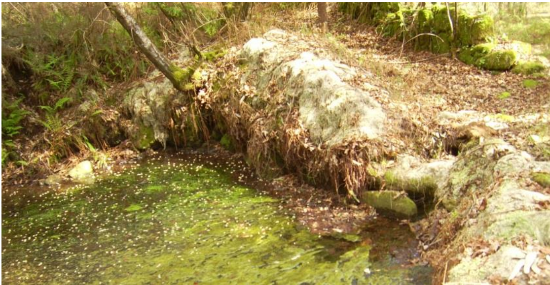
Fig. 2. Ejemplo de presa tradicional donde se pueden observar los restos de la limpieza de la misma depositados alrededor de sí, encima de las paredes, como método tradicional de autorregeneración y acondicionamiento de la construcción.
