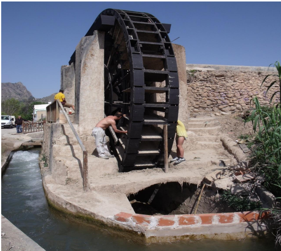
Fig.3. Reparaciones en la rueda de corriente baja “Noria Hoya de D. García”.(14/04/2014)
