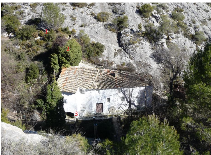
Fig. 9. Molino del Tendre o de la Tía Roseta. 1. Acequia; 2. Cubo o cup ; 3. Cárcavo o cacau .
