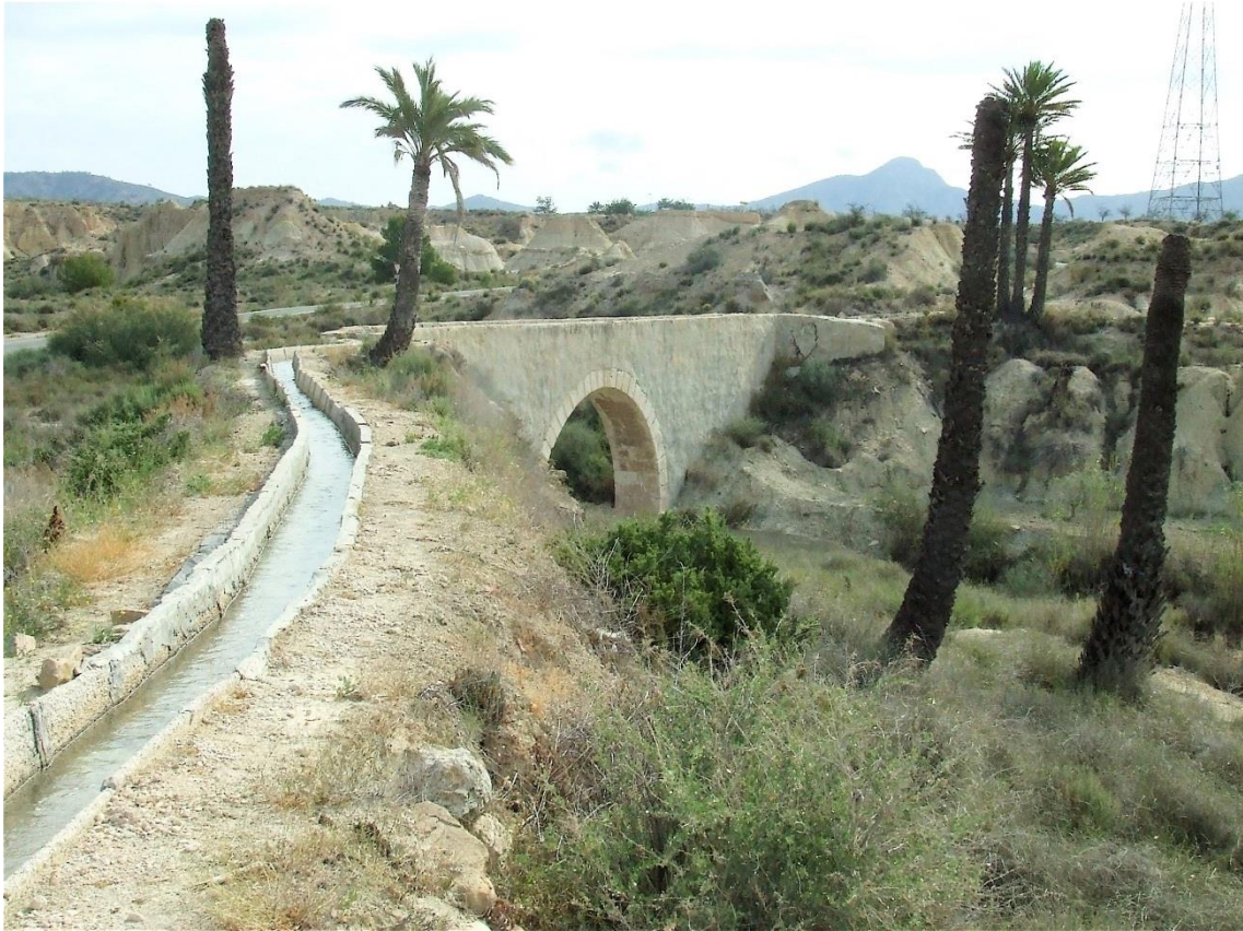
Fig. 9. Acequia que discurre hacia el Arco de M a La Reina (acueducto).
