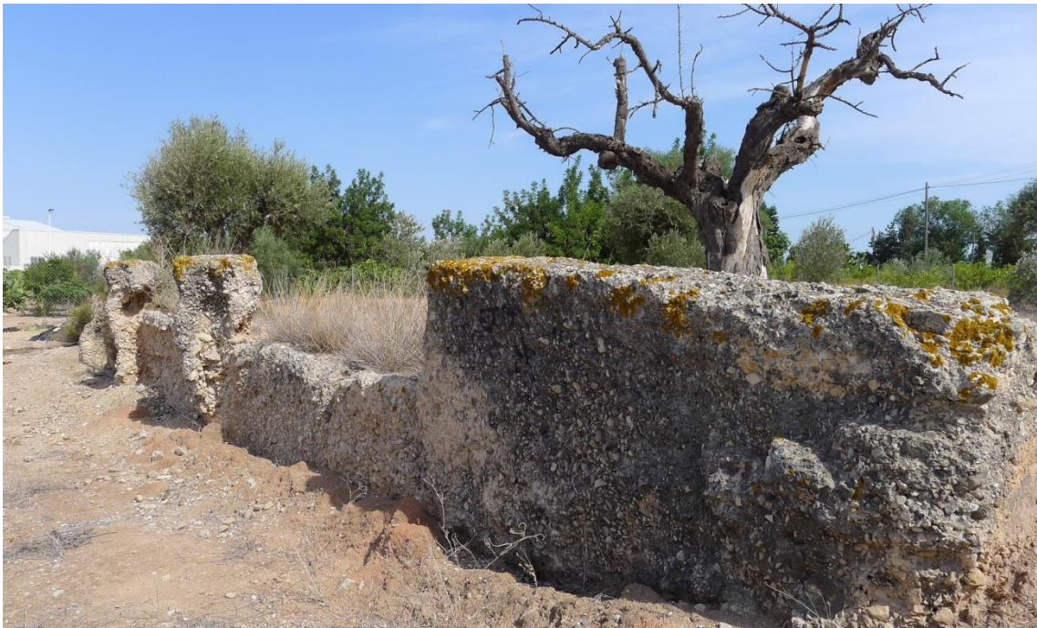
Fig. 16. Ruinas de Els Banyets. Muro y contrafuertes del lado norte.
