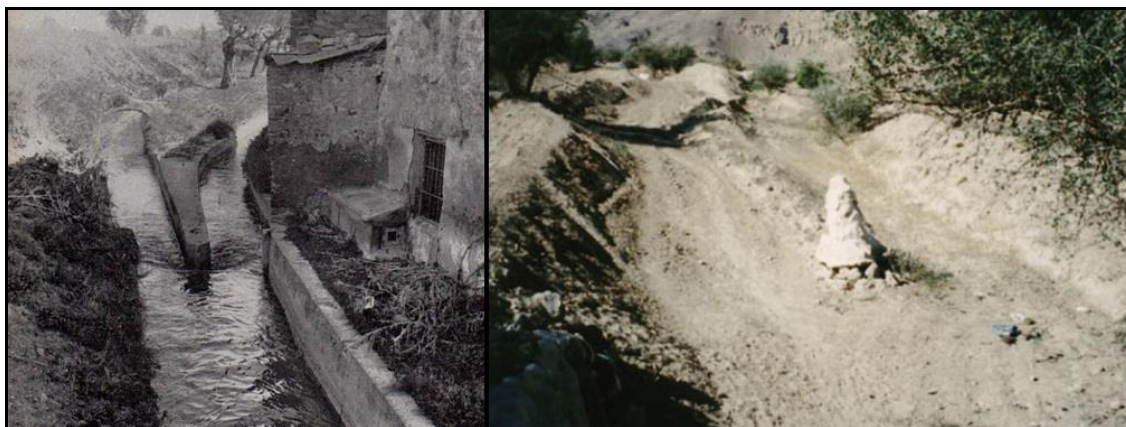
Fig. 1. A la izquierda partidor proporcional en la acequia de Tormos (huerta de Valencia) en 1956. A la derecha un partidor proporcional mucho más simple en un canal seco del valle de Hadramawt (Yemen).
