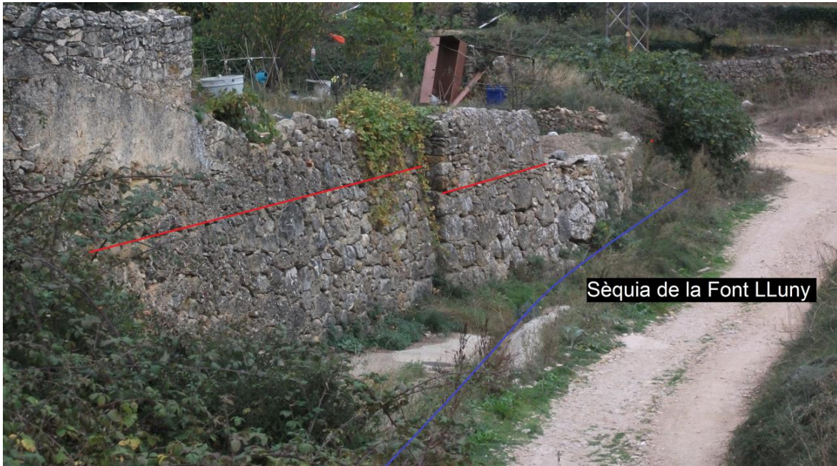
Fig. 16. Pared que separa el parcelario del lecho del río (Foto: M.Pica).
