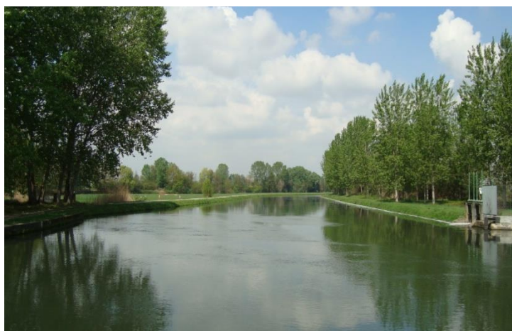
Fig. 5. Instantánea del canal de la Muzza a su paso por Paullo (Milano)
