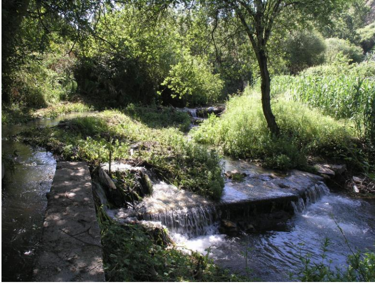
Fig. 2. Presa de la que capta el agua del río Monachil la acequia de la Estrella. ©José Castillo Ruiz.
