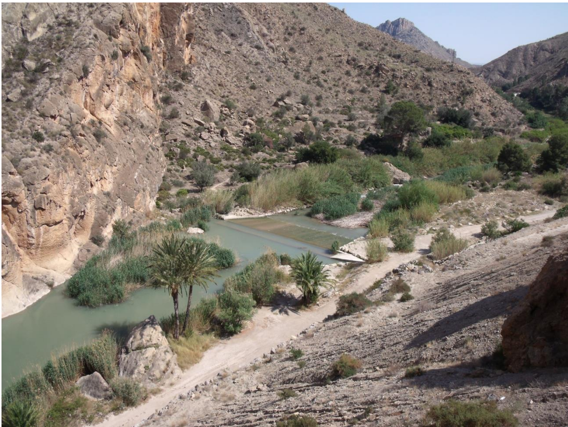
Fig.6. Estrecho de El Solvente. Antiguo azud de Ojós del que parte por su M.I., la acequia de Ulea y por la M.D.; la de Ojós y Villanueva (18/04/2014).
